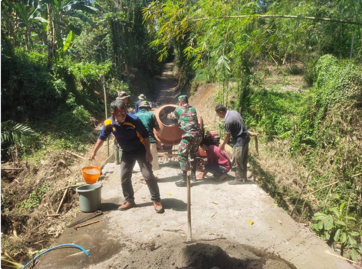
Pengecoran plat beton dengan volume panjang 3 meter, lebar 3,5 dan tebal 30 Cm tersebut, dilakukan menggunakan satu unit molen (mesin cor) dan tenaga manual dari masyarakat dan pasukan TMMMD Ke 117 Kodim 0824/Jember.
